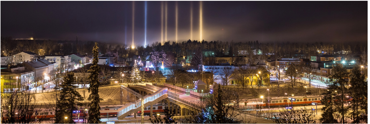
Karjaan rautatiesilta korjataan vuosina 2018-2019.
