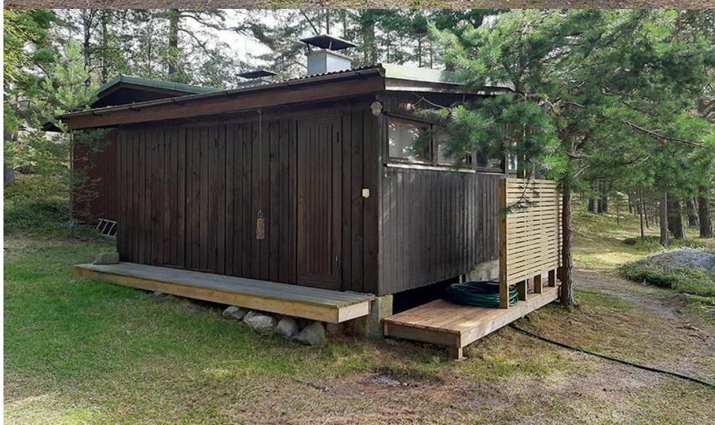
Bilder 16-17. Huvudbyggnaden avbildad från sjösidan och inlandssidan på byggnadsplats 1 i kvarter 7.
