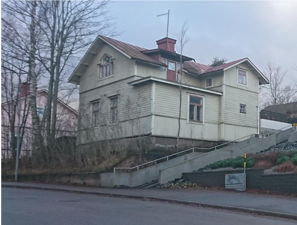
Kilantien 38 asuinrakennus. Rakennuksen pädyssä on jaottelultaan koristeellinen alkuperäinen ikkuna.
