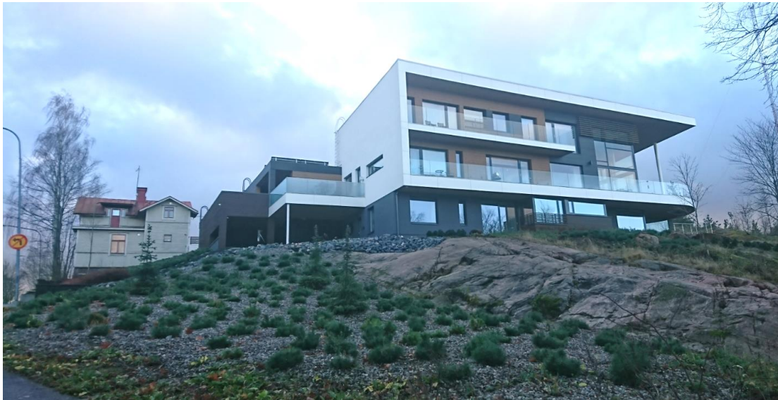
Puolukkakatu 8:n julkisivu pohjoiseen alarinteen ja aseman suuntaan.
