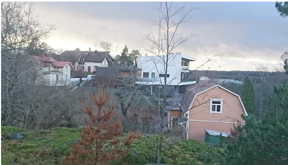
Puolukkakatu 8:n kaksi asuntoa käsittävä asuinrakennus poikkeaa selvästi mittakaavaltaan Kilantien varren muusta, varsin pienipiirteisestä rakentamisesta.
