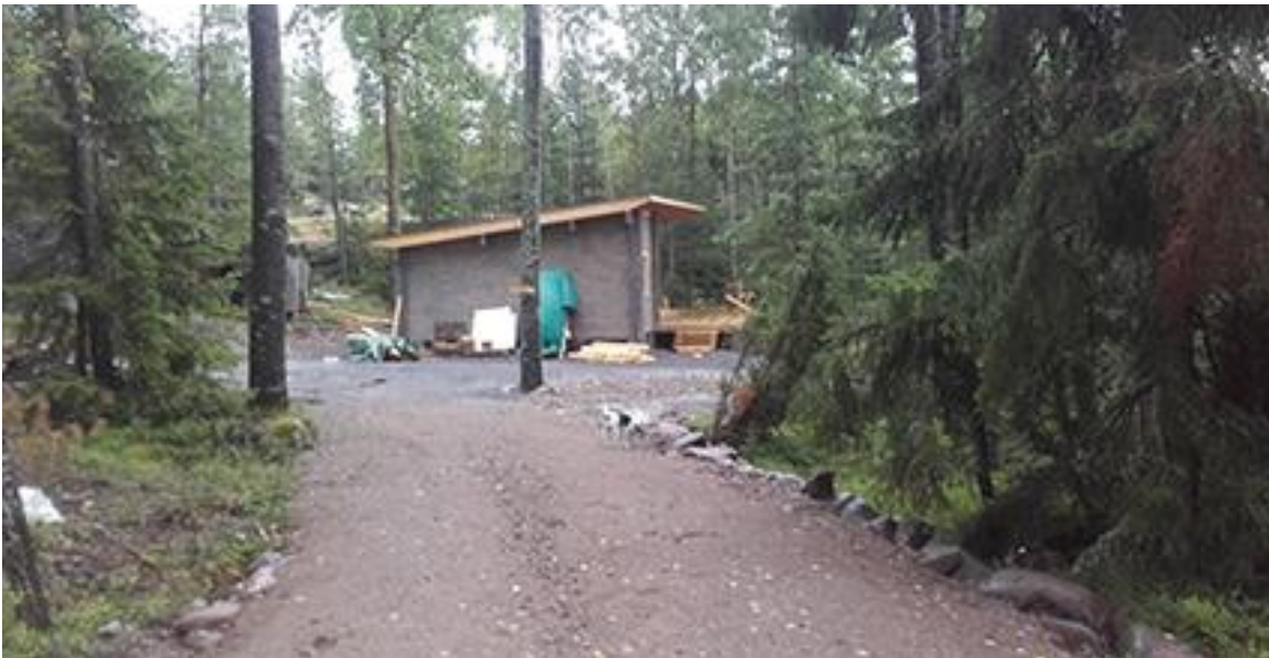
Bild 12. På byggplatsen i kvarter 5 uppförs en ny fritidsbostadsbyggnad.
