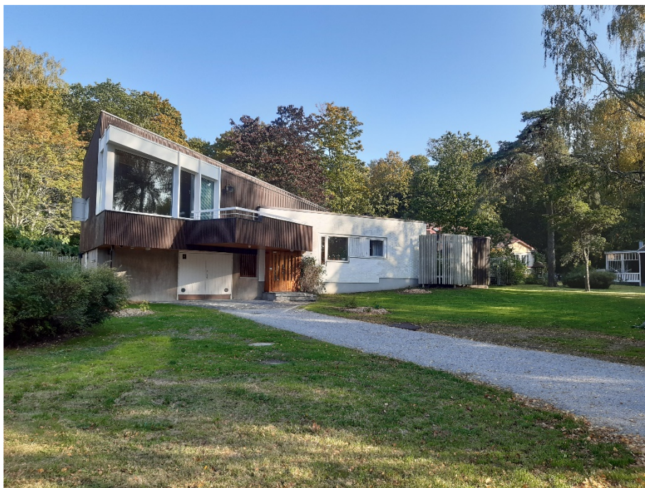
Bild 5. Villa Skeppet sett från Snäcksvägen. I bakgrunden syns en del av Villa Skutan och till höger en del av Villa Fregatten.
