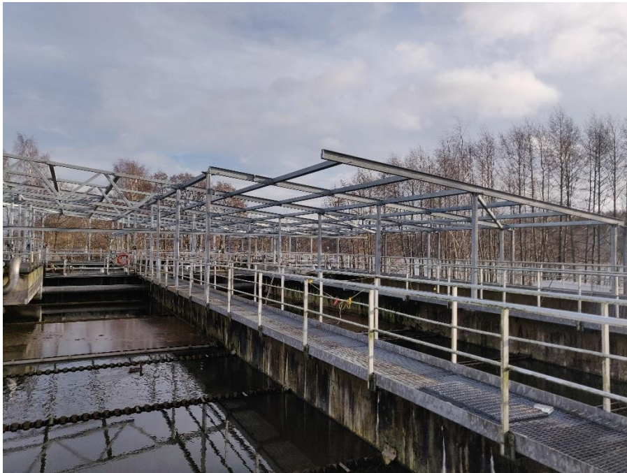
Bild 6 Bygandet av väggar och tak vid Skeppsholmens processbassänger påbörjat
