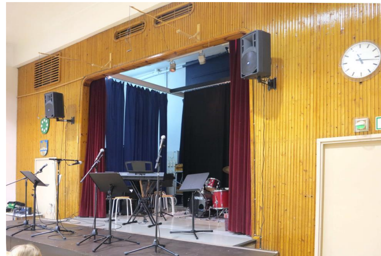
Näyttämöseinän lakattu paneeliverhous pyöristettyine kulmineen on ratkaisuna aikaudelleen tyyppillinen.
