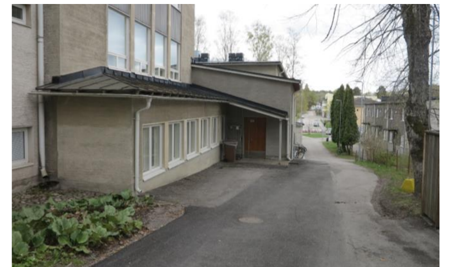
Näkymä koulun länsipuoliselta kujalta jatkuu Felix Fromin katua pitkin pitkälle keskustaan.
