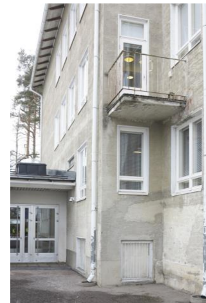
Päädyn alareunan ikkunat liittyivät alun perin vahtimestarin asuntoon. Ikkunat on myöhemmin suojattu teräsverkolla. Vuoden 1958 asemapiirroksessa on päädyn edusta istutettu. Alue on myöhemmin asvaltoitu. Vasemmalla näkyvä viistokulmainen sahanpurutilan kuisti on rakennettu 1990-luvun muutostöiden yhteydessä.
