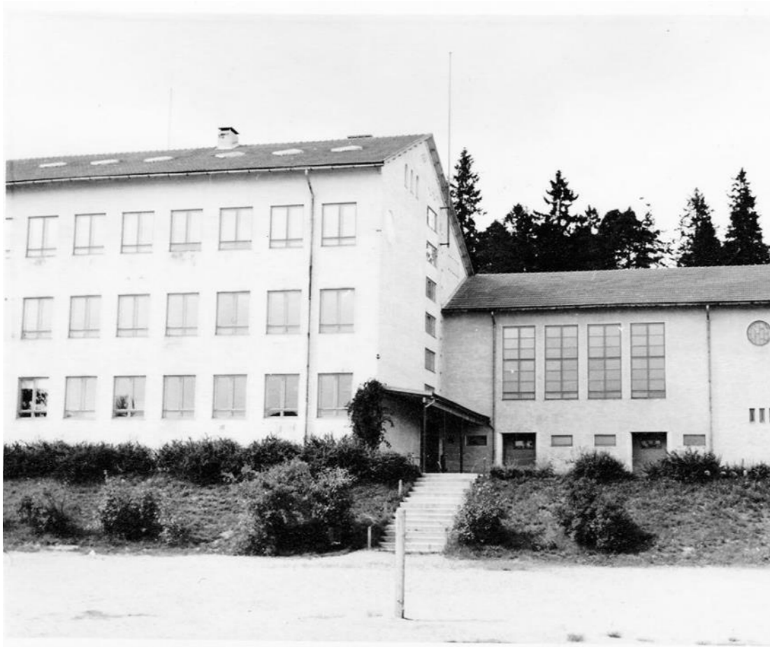
Arviolta 1950-luviulla otetussa valokuvassa näkyy alkuperäinen sisäänkäyntikatos, joka myöhemmin on uusittu. Myös päädyssä sijainnut lipputanko on poistettu. Katolla näkyvät yläkerroksen tiloihin valoa tuovat kattoikkunat. Valokuva Runar Bäckström/ Paikallisarkisto Arestin kuvakokoelma.
