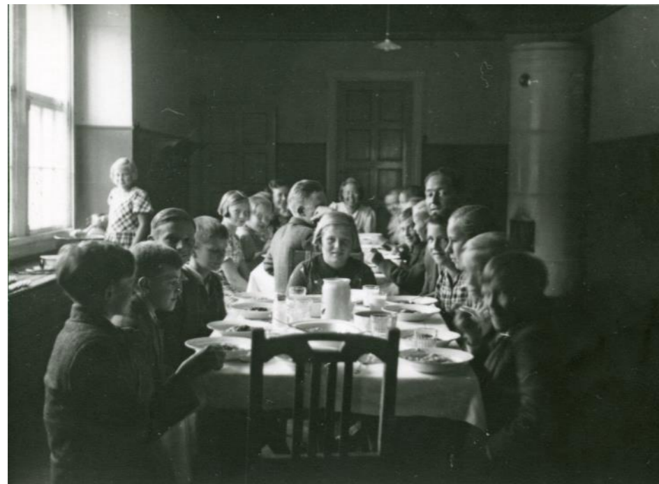
Kouluruokailua toisen kerroksen käytävässä koulun alkuvaiheessa. Paikallisarkisto Arestin kuvakokoelma.
