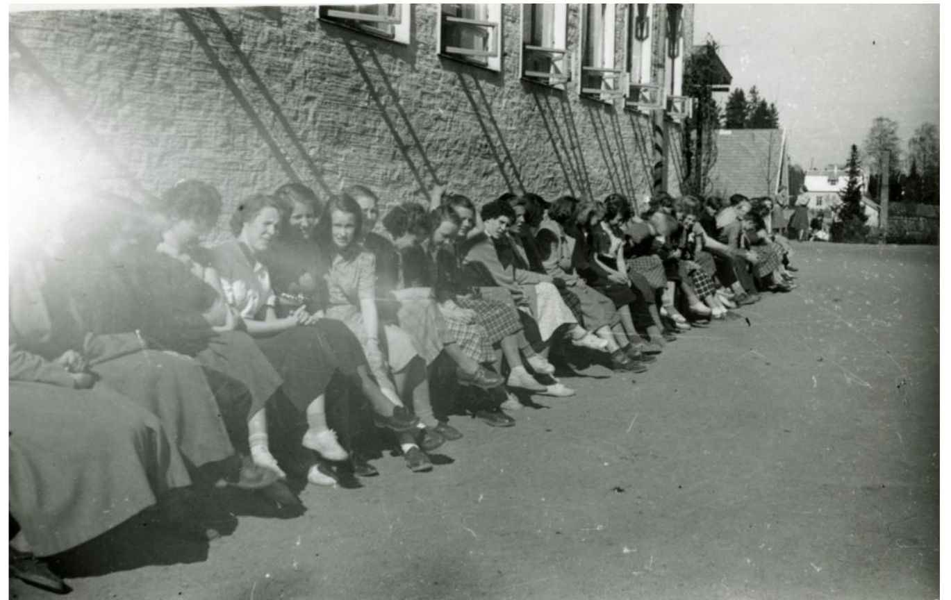
Oppilaita istumassa koulun eteläjulkisivun edustalla arviolta 1950-luvulla. Julkisivun alkuperäinen karkeastrukturinen rappaus korostuu kuvassa. Paikallisarkisto Arestin kuvakokoelma.
