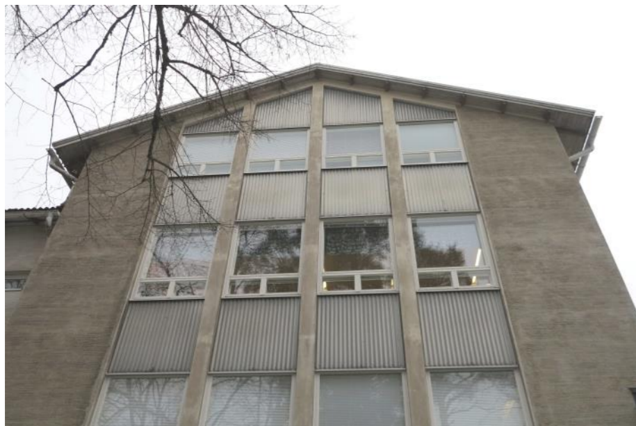
Vuoden 1958 laajennuksen länsipäädyn ikkunat on myöhemmin uusittu ja vaihdettu alumiinipintaisiksi ikkunoiksi. Alumiinipinta on jonkin verran muuttanut ilmettä, mutta ikkunat ovat kuitenkin selvästi sirommat kuin vuoden 1992 laajennuksessa käytetyt ikkunat. (ks seuraava sivu)
