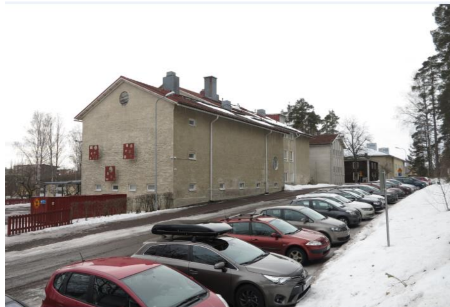
Vanhalla osalla säilynyt rappaus on paikoin jo kulunut. Korkeamman osan päätyä jäsentävät erilaiset koristeikkunat. Poistetun kellon paikka näkyy pyöreänä syvennyksenä, samaten lipputangon pidikkeet. Juhlasalin päädyn julkisivuja koristavat neliömuotoiset rei'itetyt levyt. Pyöreän koristeikkunan tilalla on myöhemmin asennettu ilmastointiritilä.
