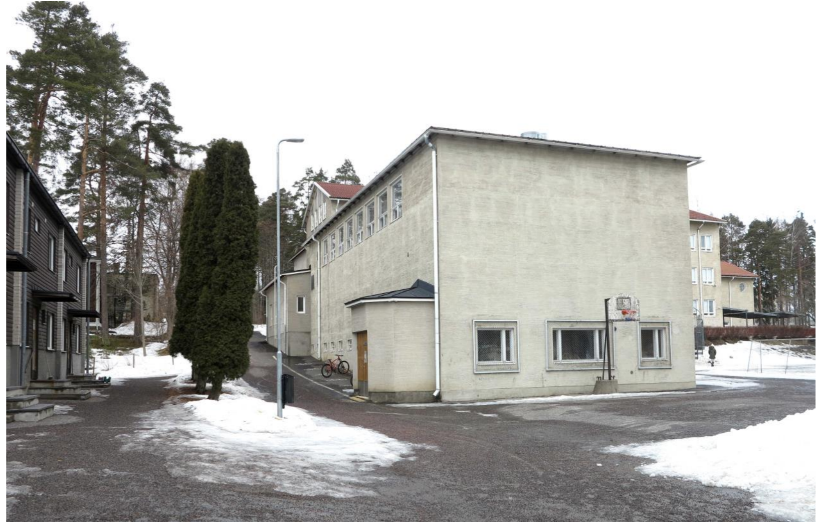
Päädyn alareunan ikkunat liittyivät alun perin vahtimestarin asuntoon. Ikkunat on myöhemmin suojattu teräsverkolla. Vuoden 1958 asemapiirroksessa on päädyn edusta istutettu. Alue on myöhemmin asvaltoitu. Vasemmalla näkyvä viistokulmainen sahanpurutilan kuisti on rakennettu 1990-luvun muutostöiden yhteydessä.
