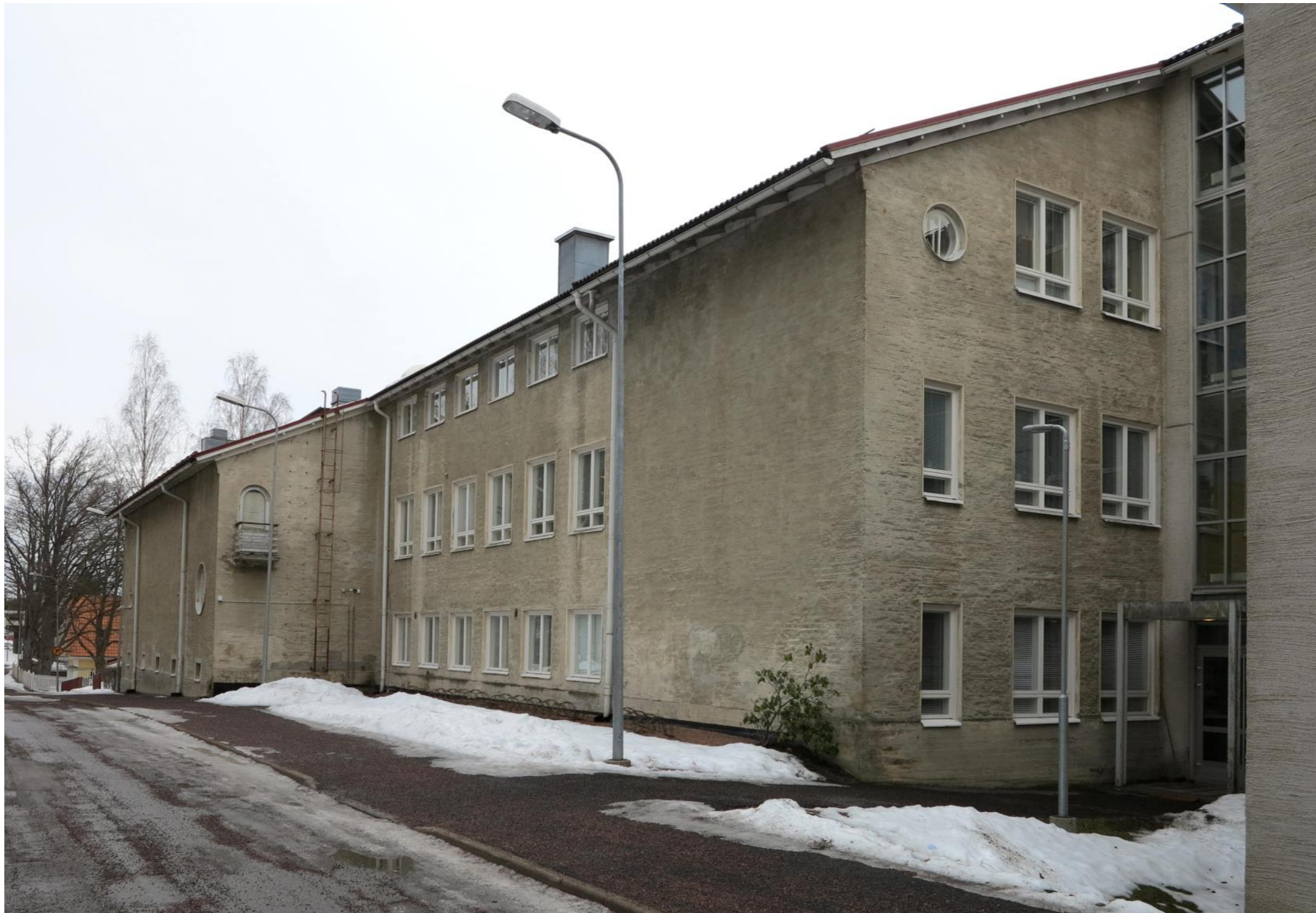
Vanhimman osan julkisivu Naapurinkadun puolella on säilynyt alkuperäisenä. Siinä korostuvat erityisinä yksityiskohtina pyöreät ikkunat ja juhlasalin parveke sekä harjattu jo ilmeeltään paikoin kulunut rappauspinta.
