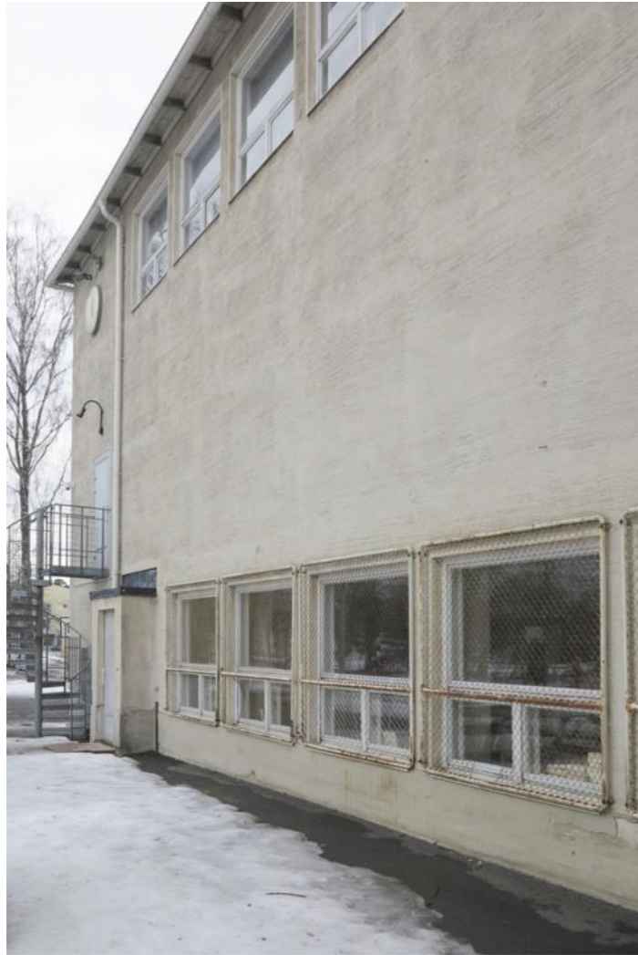
Veistosalin pihan puoleiset ikkunat on suojattu teräsverkolla
