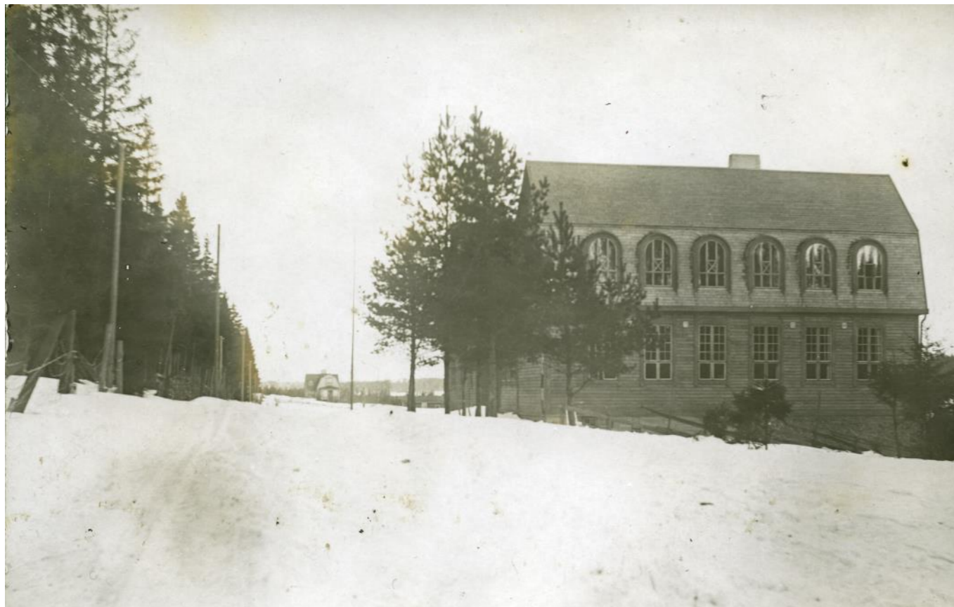
Koulurakennukseen kuljettiin Naapurinkadulta, sisäänkäynti jää kuvassa puuryhmän taakse. Naapurinkadulta otettu kuva on vuonna 1918 rakennetun toisen koulurakennuksen alkuvuosilta, jolloin julkisivut olivat edelleen hirsipintaiset ja katto paanuverhoiltu. Karjaan ja Pohjan raja kulki vasemmalla näkyvän riukuaidan kohdalla. Kuva Arkisto KBS/Paikallisarkisto Arestin kuvakokoelma.
