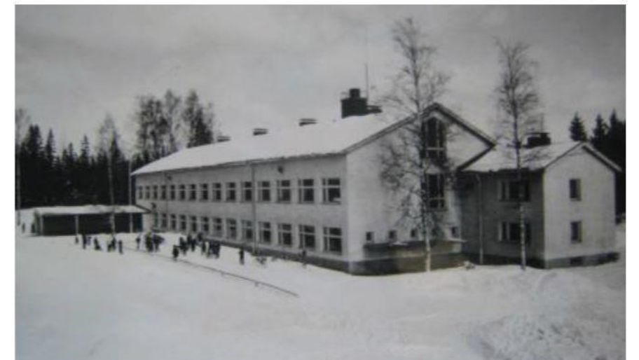
Risto-Veikko Luukkosen vuonna 1951 laatima luonnos-suunnitelma (ylempi kuva ) ja vuonna 1955 valmistunut Leppäkorven koulu, Vantaa.. Kuva Leppäkorven koulun kuva-arkisto.
