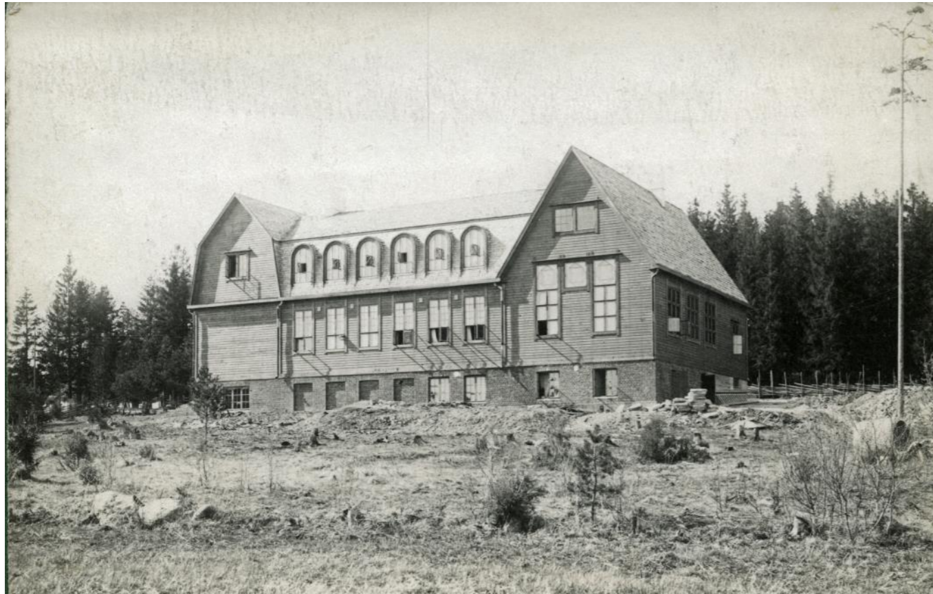
Oletettavasti keväällä 1919 otettu valokuva vastavalmistuneesta, toisesta koulurakennuksesta. Koulun edusta on vielä siistimättä rakennustöiden jäljiltä. Eri tyyli-aiheita yhdistelevään taitekattoiseen rakennukseen liittyi sekä taitekattoinen että satulakattoinen poikkipääty ja erityyppisiä suurikokoisia ikkunoita. Tilatarpeen lisääntyttä toteutettiin aiemmasta rakennuksesta poiketen myös toiseen kerrokseen luokahuoneita joihin liittyi lappeeseen upotetut suuret ylösastaan kaarevat ikkunat. Kuva Arkisto KBS/Paikallisarkisto Arestin kuvakokoelma.
