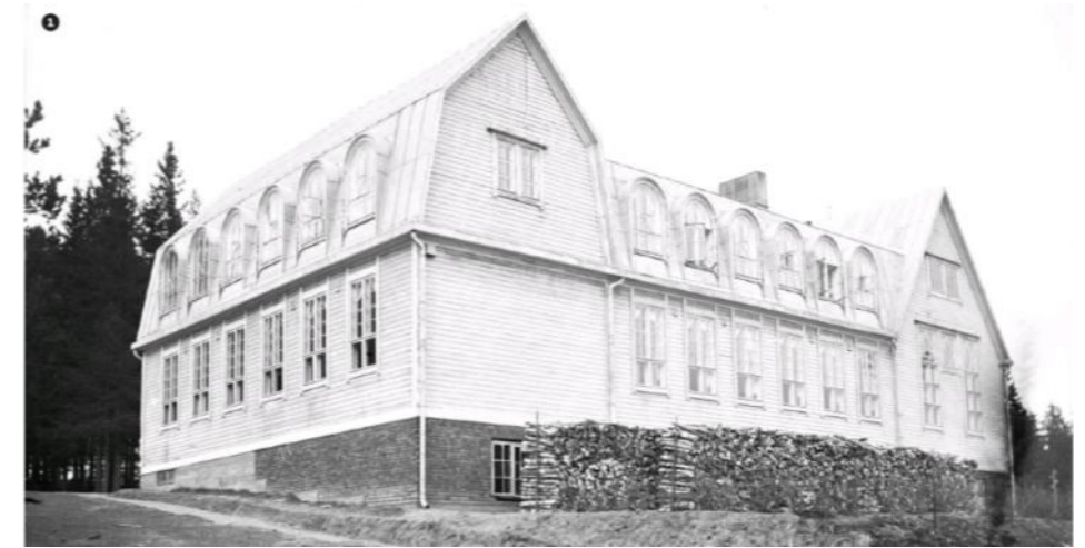
Koulun katto sai peltiverhouksen vuosina 1927-1928. Julkisivut ovat kuvassa saaneet vaalean sävyisen vaakapaneeliverhouksen. Myös ikkunoiden vuorilaudat ovat vaaleat. Kuva Paikallisarkisto Arestin kuvakokoelma.
