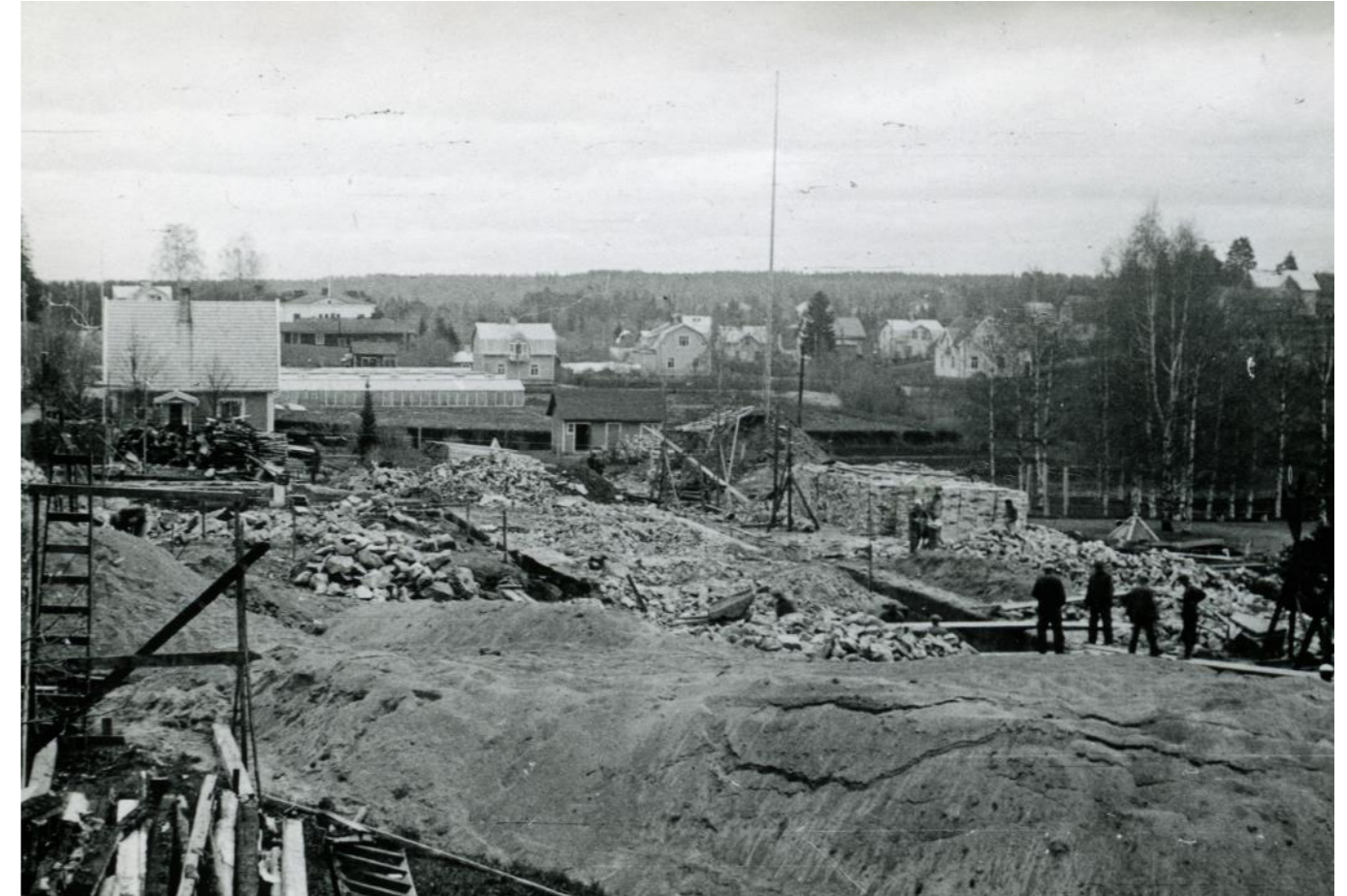
Koulun rakennustyömaa vuonna 1942. Taustalla näkyy peltoalueelle pääosin 1930-luvun aikana muodostunutta uutta asutusta. Paikallisarkisto Arestin kuvakokoelma.
