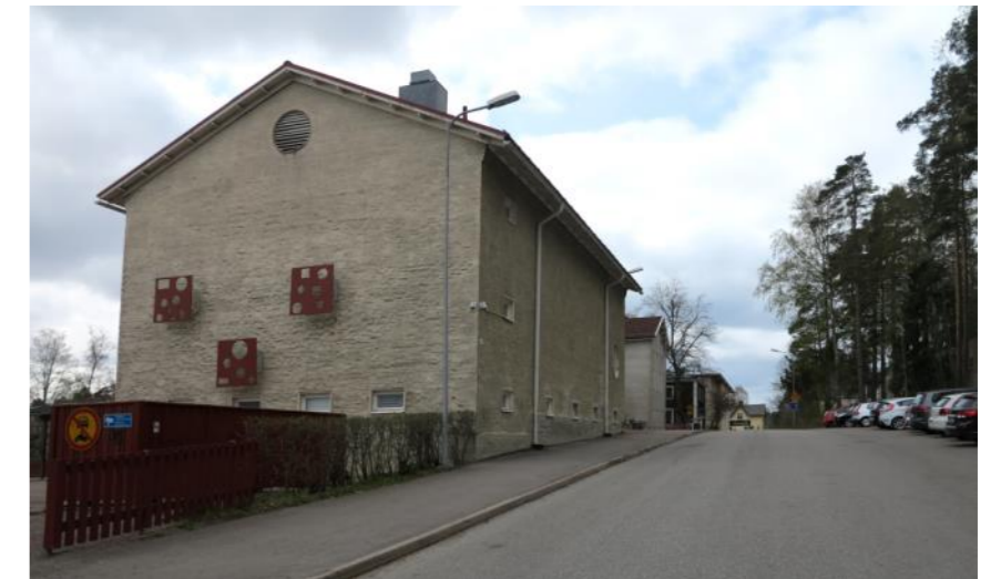
Koulun vanhin osa sijoittuu tiiviisti Naapurinkadun katulinjaan.
