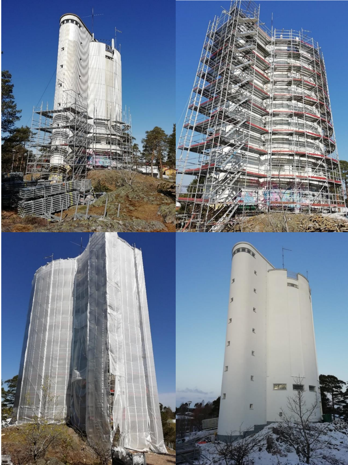
Karis vattentorn i olika skeden av saneringen, 2019.
