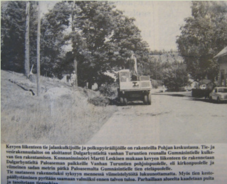
Kevyen liikenteen tie rakenteilla Pohjan keskustassa. KS 6.8.1981
