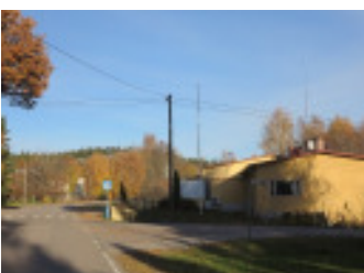
Vuonna 1962 rakennettua entistä Varubodenin kiinteistöä on myöhemmin laajennettu ja muutettu. Rakennuksessa on aiemmin toiminut mm ravintola.
