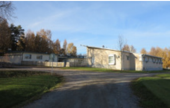
1962 rakennettu arkkitehti Paula Pihkalan suunnittelema terveyskeskus sijoittuu aivan kirkon muurin viereen vanhan tielinjauksen reunaan. Rakennuksen myöhemmät laajennukset 1989 ja 1992 ovat muuttaneet sen ilmettä kyläkuvassa.
