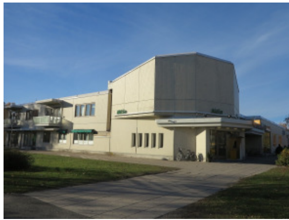
Säästöpankin ja Varubodenin yhteishankkeena toteutettu Pohjankulman liikerakennus 1980-luvulta rakennettiin Kapernaumin tontille Vanhan Turuntien ja Pohjantien kulmaan.
