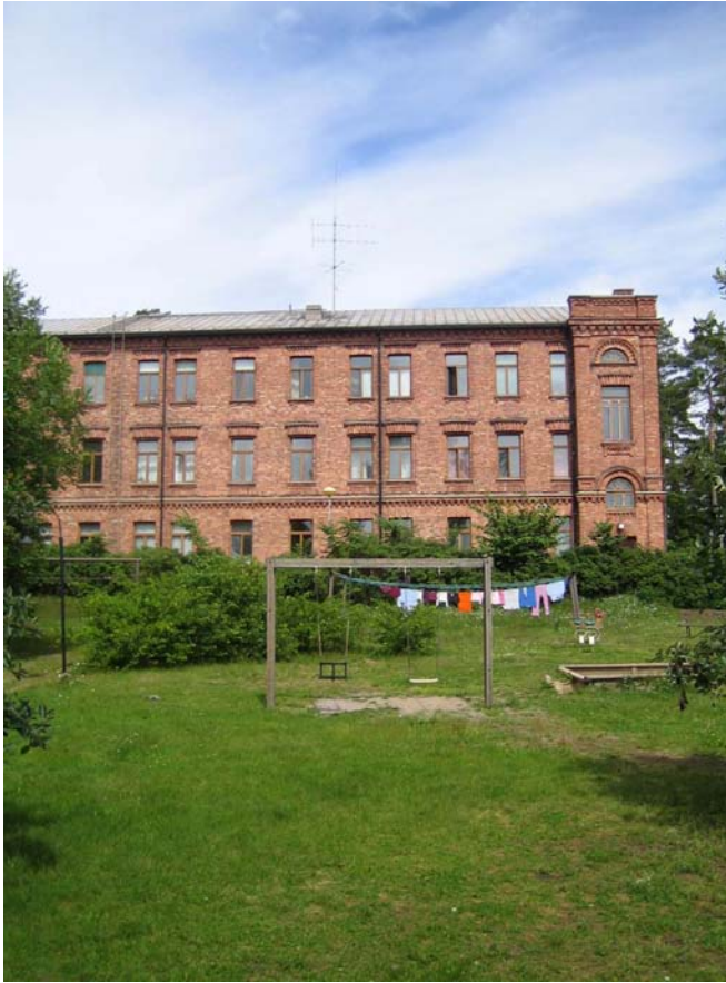
Bild 19. Gårdsvy vid bostadshuset.
