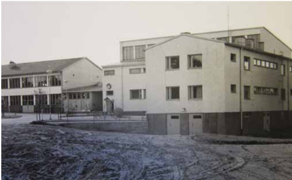
Yrkeskolans tillbyggnader i sluten av 1960-talet. Källa: Den byggnadshistoriska utredningen.
