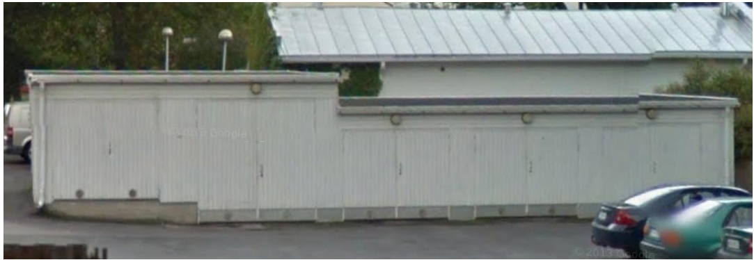
Garage- och servicebyggnaden på tomt 285.
