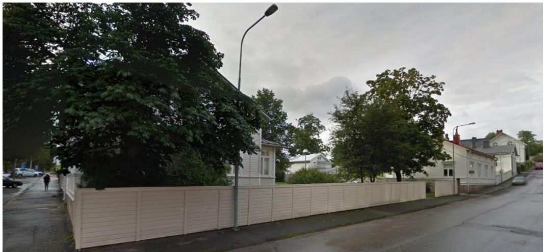
Byggnaderna mot Sigfrid Aroni gata.
