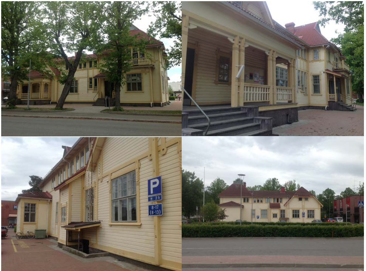
Bild 12. Bildsammanställning av Villa Hagas byggnad. (bilder ur den byggnadshistoriska inventeringen, Björklund 2015)
