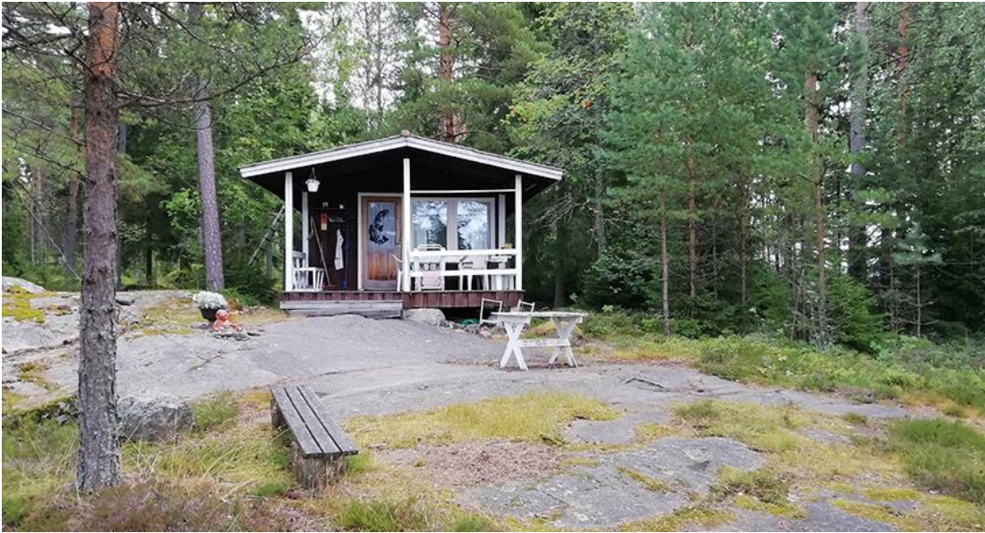
Bild 11. Stugan på byggnadsplats 1 i kvarter 6.
