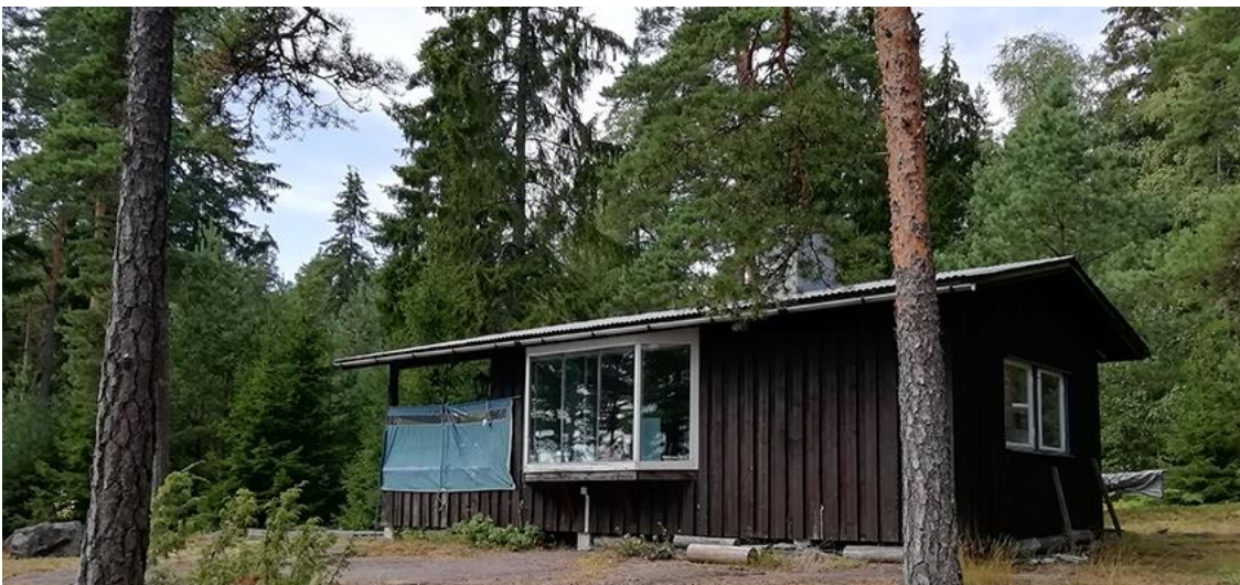
Bild 13. Stugan på byggnadsplats 4 i kvarter 6.
